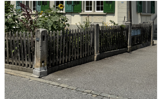
Beispiel Holzlattenzaun mit Betonsockel
