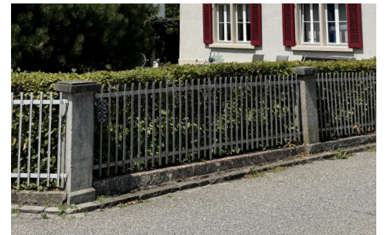
Beispiel Metallzaun mit Betonsockel
