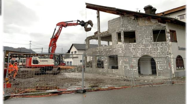
Die Abrissarbeiten auf der Parzelle Nr. 261 im November 2023
